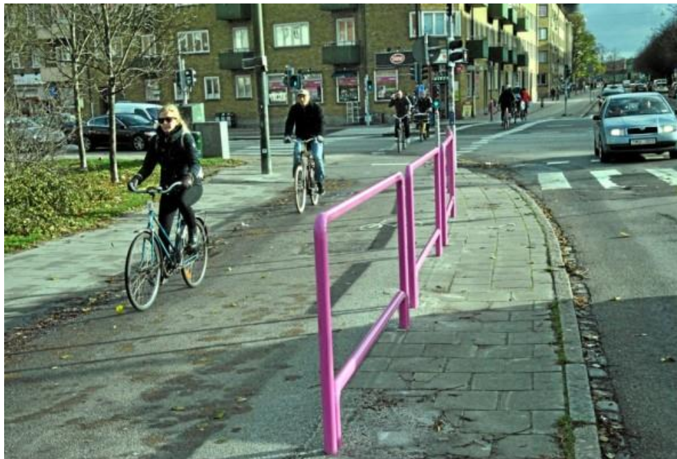
Figur 2-3 Rosengårdsstråket är ett upprustat gång- och cykelstråk som förbinder Rosengård med Malmö mer centrala delar.
