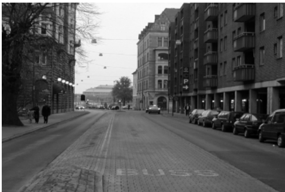
Figur 7.4 Norra delen av "Djäknegatan", d v s Mäster Nilsgatan norr om Själbodgatan, efter ombyggnad (foto: PG Andersson)
