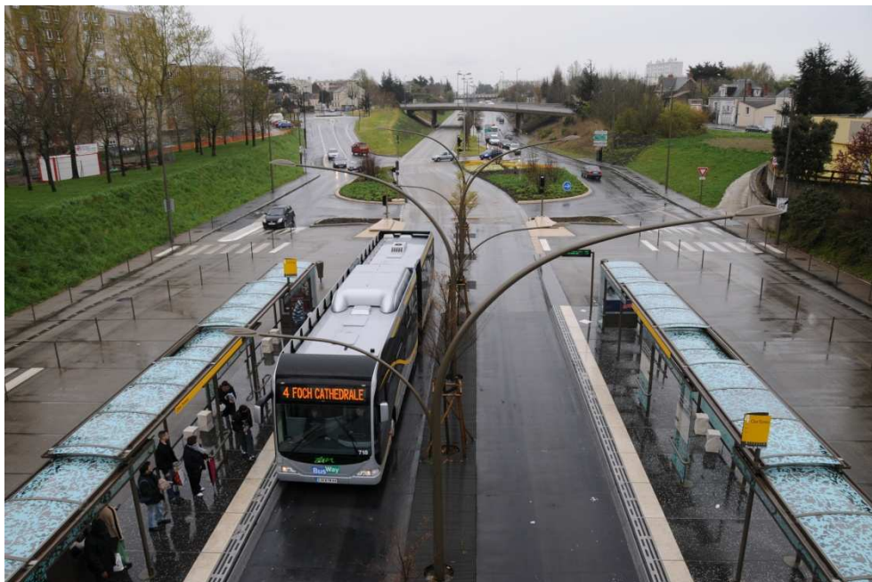
Figur 2-2. Stationerna på BusWay i Nantes är i princip utrustade som järnvägsstationer med rymliga vädterskydd, biljettautomater och realtidsinformation om avgångstider. Plattformen är i samma nivå som insteg i bussen.
