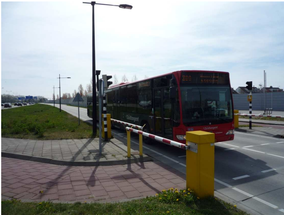
Figur 4-1. På bussbanan Zuidtangent utanför Amsterdam förekommer korsning med bommar, en lösning som annars mest figurerar vid järnvägar.
