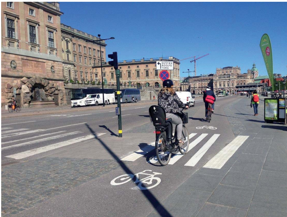
Figur 7-6 Skeppsbron efter åtgärd (vägmärkning Övergångsställe, vita kupolplattor på ömse sidor om gångpassagen, cykelsymboler). Platsen är belägen vid bilkorsning. Cykelbanan som är enkelriktad är cirka 1,2 meter bred.
