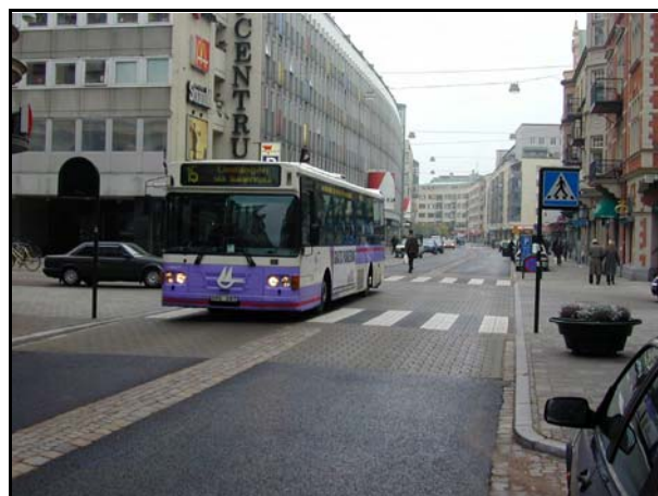
S Förstadsgatan, Malmö. Korsningens avvikande beläggning varnar för konfliktpunkten. Optiskt är gatan med busstrafik genomgående.
