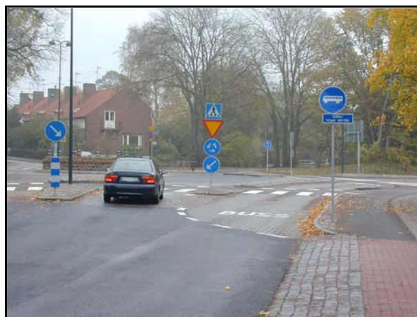
Busskörfältet måste markeras tydligt. Dalbyvägen, Lund.
