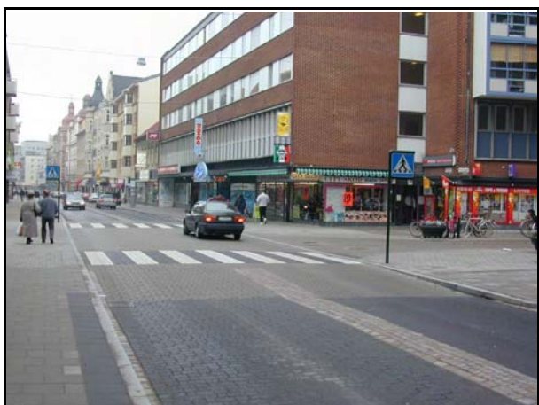
Upphöjd korsning med bussanpassade ramper och avvikande beläggning. S Förstadsgatan, Malmö.
