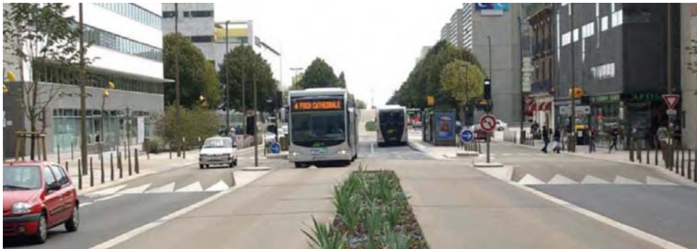
Figur 5-19 Mittförlagda busskörfält med hållplats i Nantes, Frankrike. Bilarnas körfält är upphöjt strax innan plattformen där övergångsställen finns. Källa: COST TU0630 BHLS, Buses with High Level of Service, slutrapport
