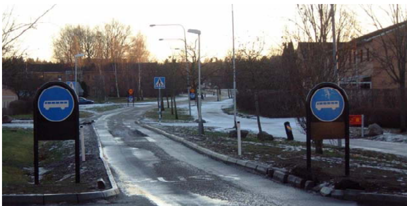
Figur 2.13 Bussgata med spårviddhinder i Lambohov, Linköping
