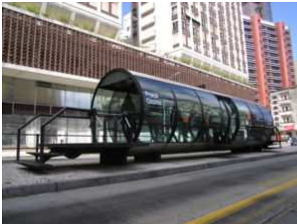
Figur 2.14 BRT-hållplats i Curitiba, Brasilien
