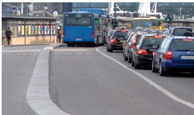
Figur 3.21 Mittkörfält separerade med målad linje mot biltrafiken. Betongkanten i mitten av körbanan hindrar biltrafik att korsa busskörfälten. Skeppsbron Stockholm. (Foto: Karl Kottenhoff)
