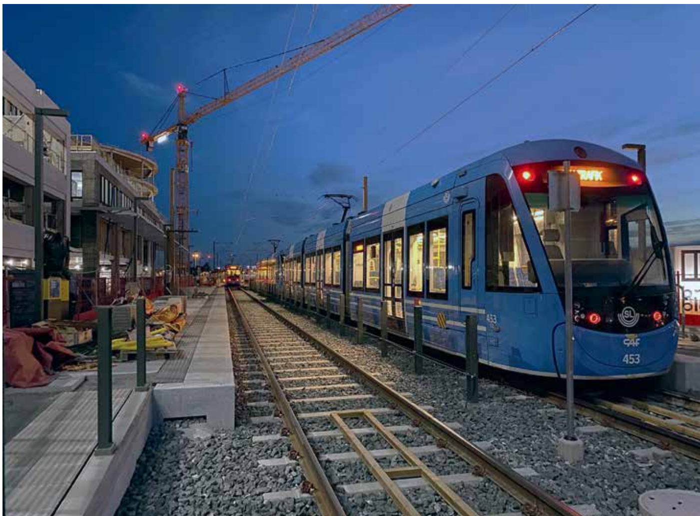
Den 24 juli provkördes för första gången sträckan mellan Norra Ulvsunda och Bromma flygplats. Här görs uppehåll vid hållplatsen Bromma Blocks som är byggd på en viadukt.
