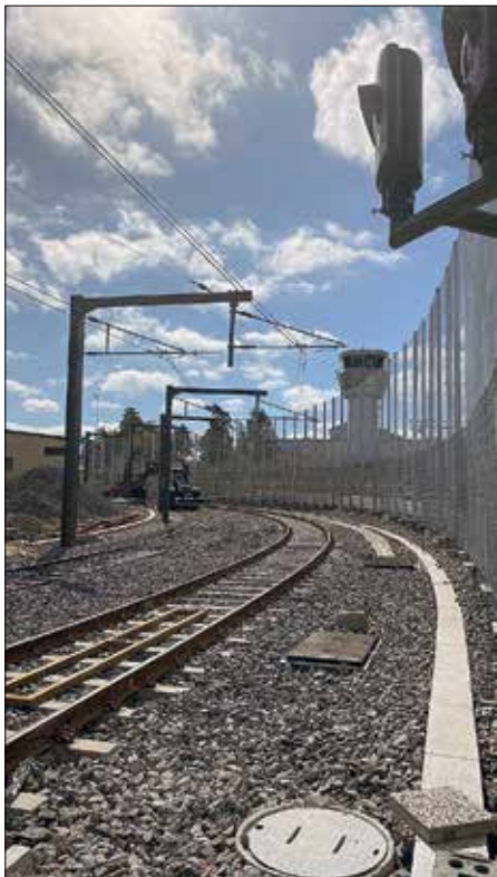
Kontaktledningsupphängningen i kurvan vid södra infarten till hållplatsen Bromma flygplats. Foto: Martin Lindahl
