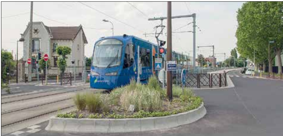
Linje T4 skapades genom att bygga om en tidigare järnvägslinje på samma sträcka, dock delvis enkelspårig. De många plankorsningarna av järnvägstyp ersattes av konventionella spårvägs-korsningar, som exempelvis här, där en ny cirkulationsplats, med blinkade röda ljus, blev en smidigare lösning.
