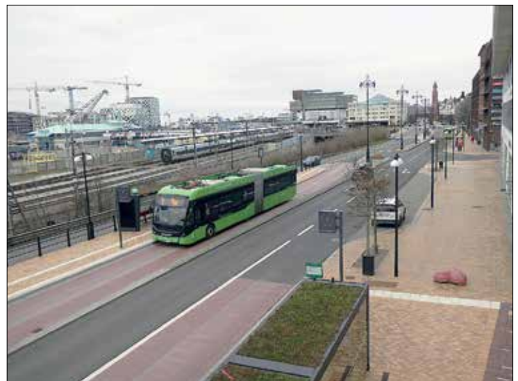
Vid Rådhusstorget i Helsingborg har busstrafiken sedan juni 2019 egna busskörfält. Ombyggnaden av Drottninggatan och Järnvägsgatan tog lång tid och har i princip inneburit att kollektivtrafiken återfått de ytor som tidigare innehades av spårvägen. Bild från december 2019.
