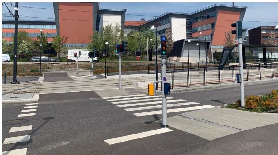
Figur 15. Den signalreglerade övergången vid hållplats Telefonplan. Källa: Bengtsson & Gertson (2021).
