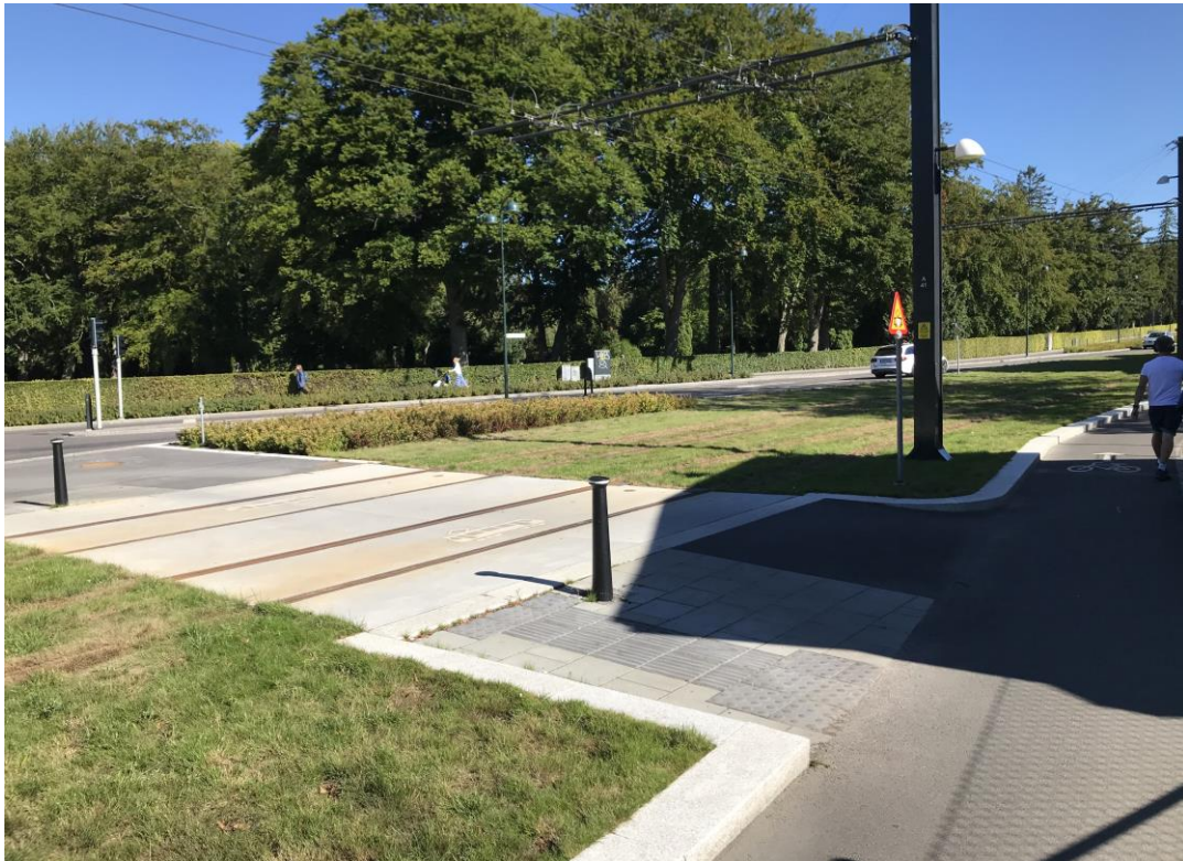
Figur 3- Den vita linjen är en ljus granitsten som löper längs hela spårvagnssträckningen för att visa var spårområdet börjar och varna trafikanter. I bilden visas också markering av spårvagn i marken samt pollare med taktil information som använts längs spårvägen. Bilden är tagen vid Getingevägen/Kung Oscars väg.
