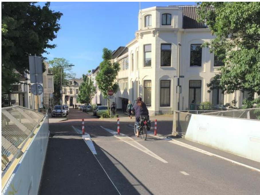
Figur 9 Cykelvänligt infartshinder i form av pollare med tillräcklig utrymme mellan för att kunna passera med större cykelfordon. Källa: Krister Isaksson, Bicycling.se
