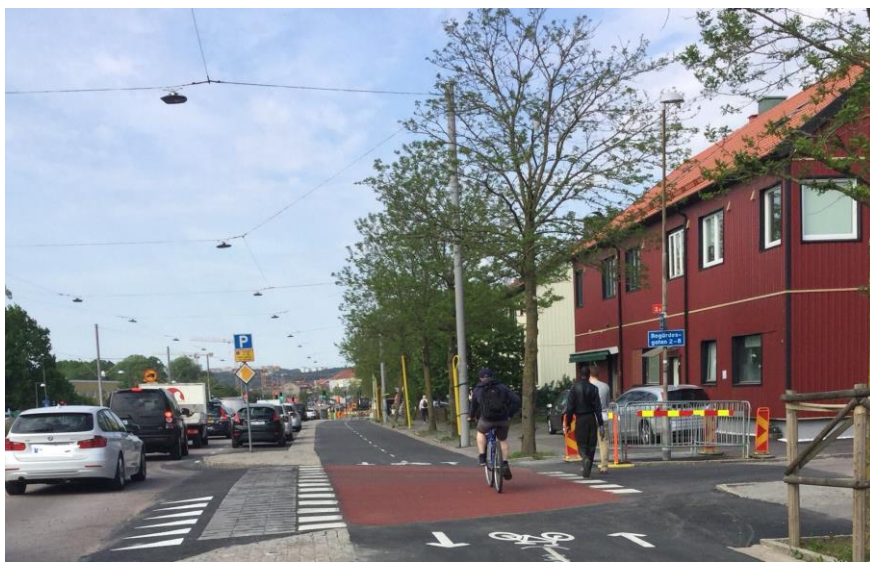
Figur 11 Rak cykelpassage över anslutande väg som möjliggör bekväm och säker cykling. Bildkälla: Erik Sandblom, korsning Bogärdesgatan/ Munkebäcksgatan i Göteborg
